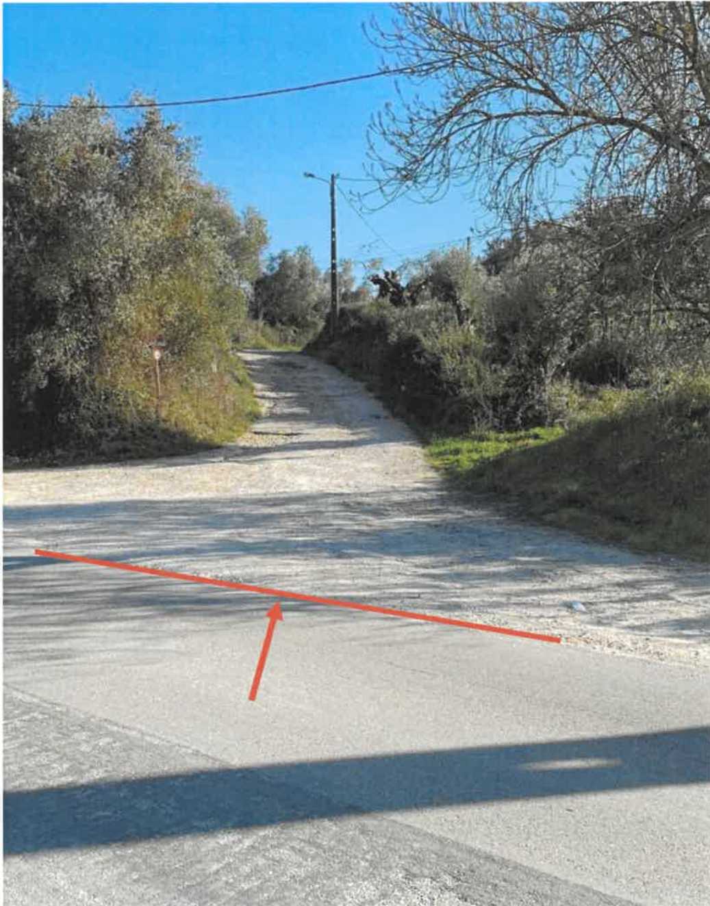
Início dos trabalhos (Rua do Vale Pereiro) → No encaixe com o pavimento betuminoso existente na Rua 25 de Abril
